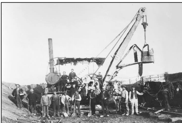
Anlæg af Slagelse-Værsløv banen ved Høng, 1896
