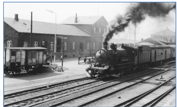
Damp tog på den gamle Kalundborg St, 1957.
